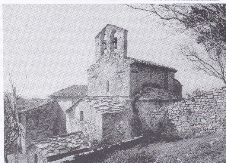
Eglise de Saint-Martin-les-Eaux, avant et après restauration
