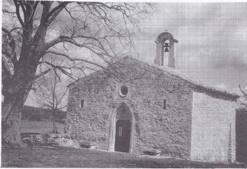
La façade occidentale de Saint-Pierre de Viviers
