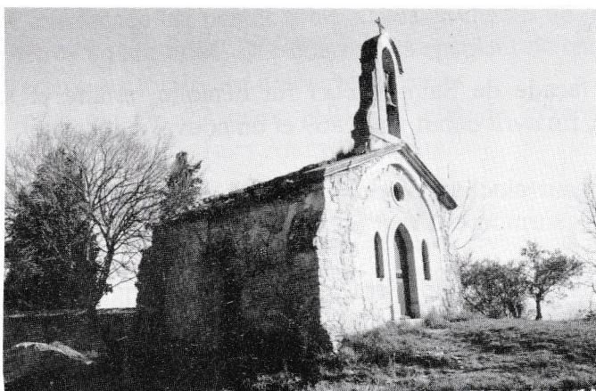
Façades nord-ouest et ouest
