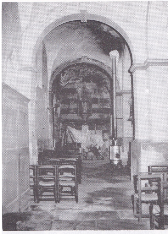
Nef et sanctuaire de l'église.
