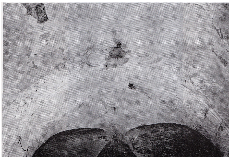
Décor de gypserie de l'arc séparant les deux travées de la nef.
