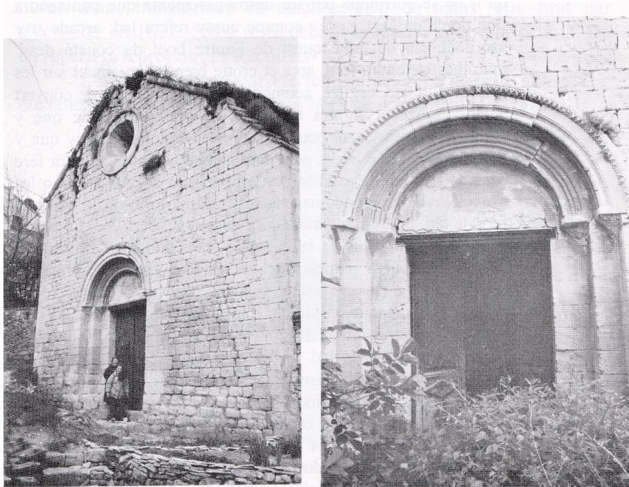
Façade et portail de l'église Saint-Jean dans leur état actuel. Ph. Jean Testanière.
