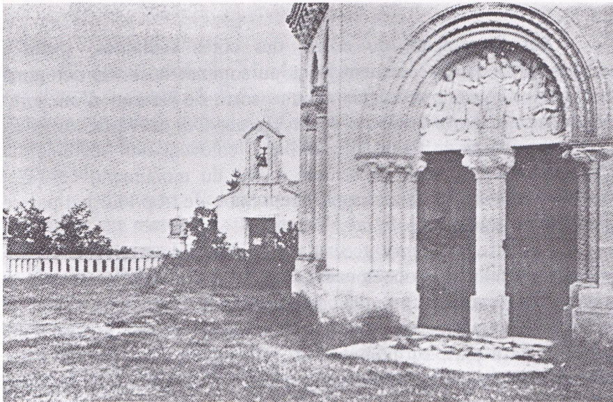
Vue de la chapelle près de laquelle se dresse encore la chapelle provisoire élevée en 1856. (coll. particulière)
