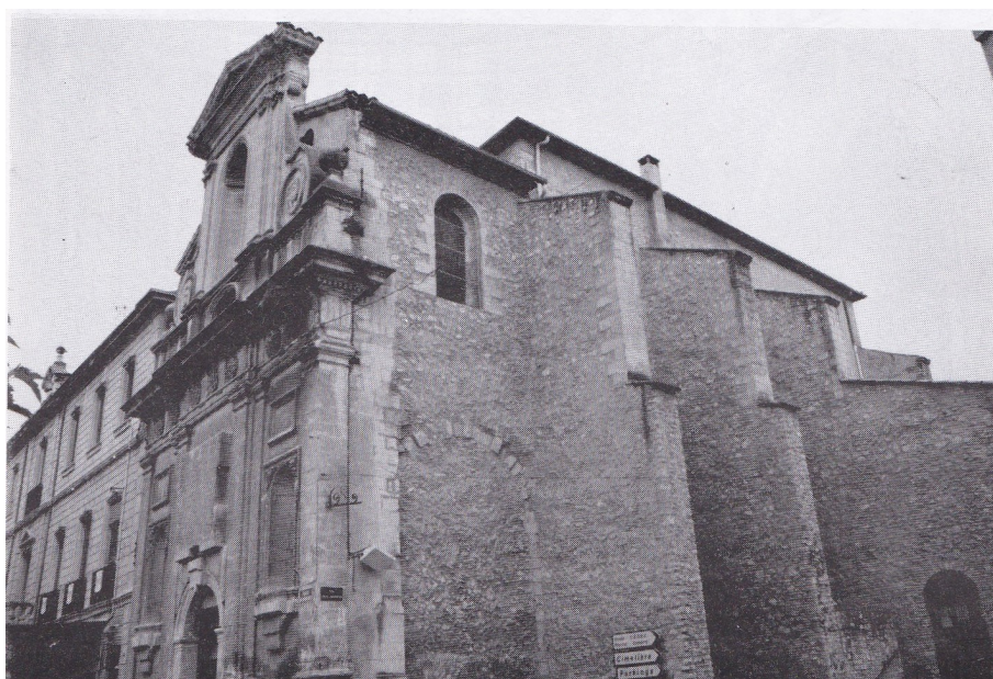
Façade orientale de l'église.
