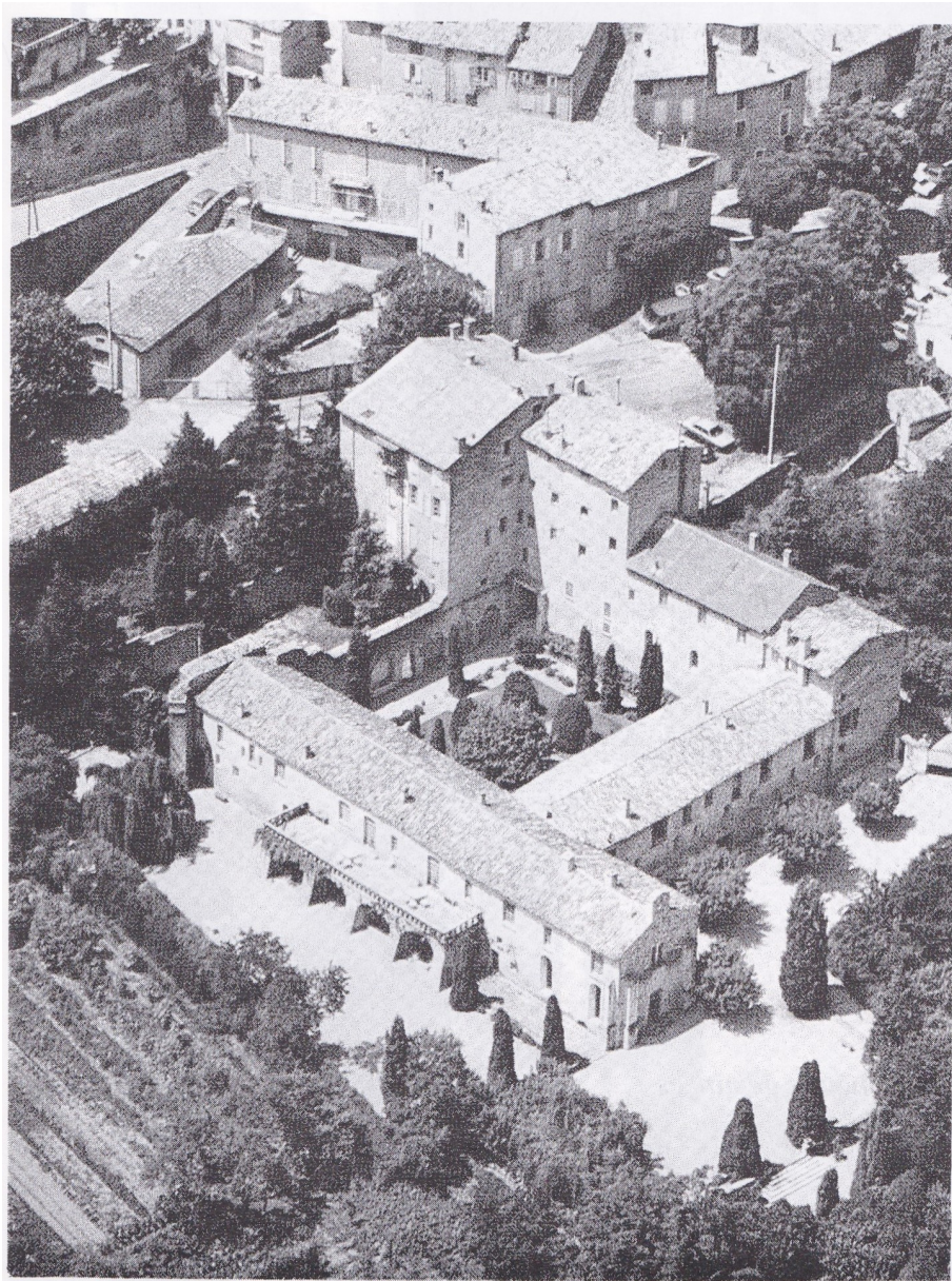
Vue aérienne du couvent des Cordeliers. Ph. C. Ansaldi.
